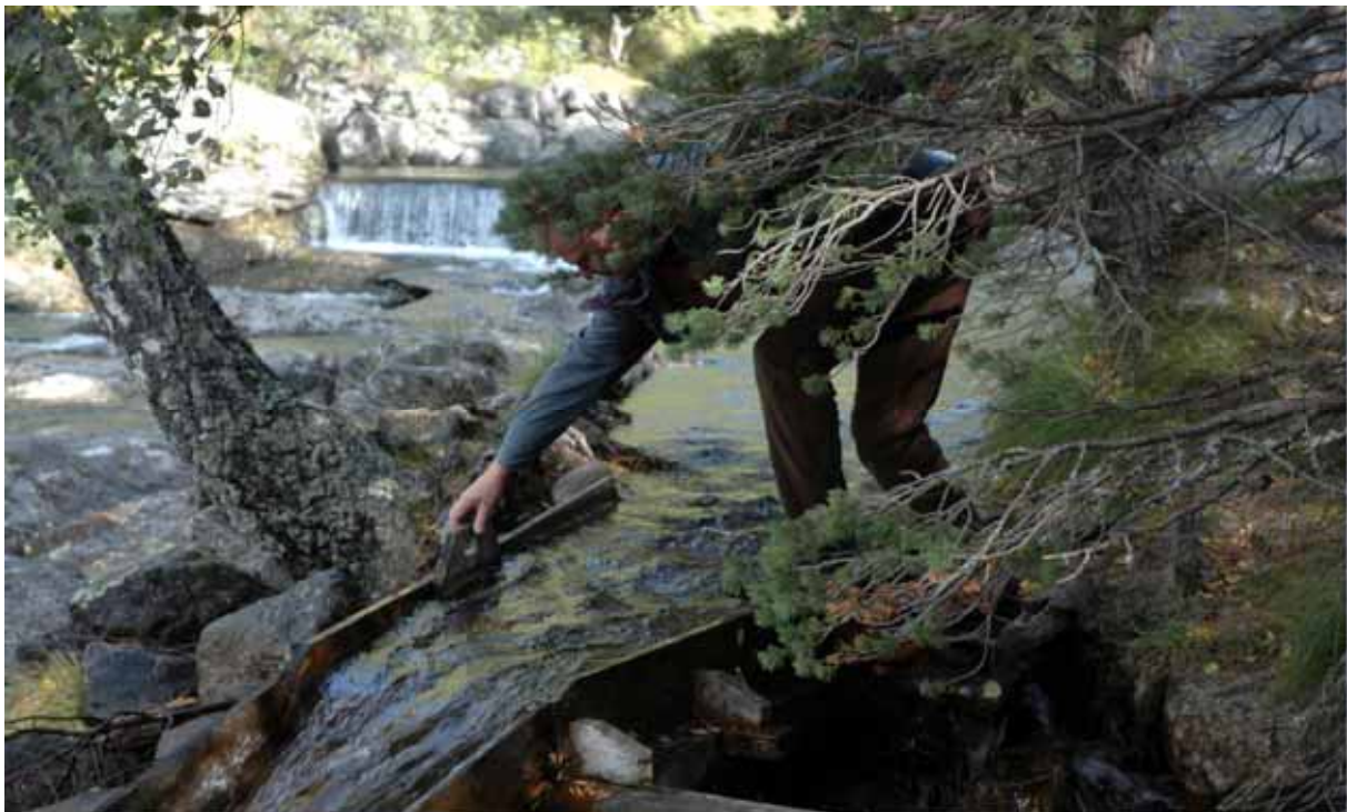
Figur 116. Vatnet blir sleppt inn i renna ved at ein opnar stengselet. Foto: Tanaquil Enzensberger
