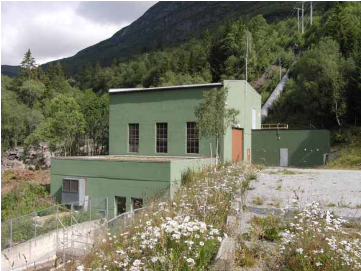
Figur 171. Nye Eidsfoss Kraftverk vart bygd i 1952. Biletet er frå 2015. Foto: PeltonMan
