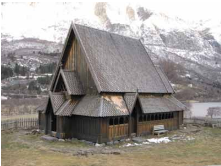
Figur 40. Øye etter restaurering gjennom stavkyrkjeprogrammet (2001–2015) til Riksantikvaren. Foto: Katharina Sparstad
