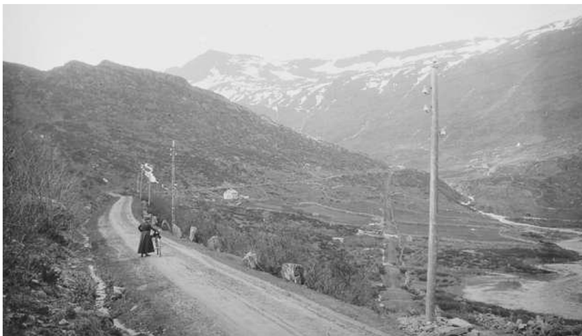
Figur 81. Kongevegen går til høgre i biletet og syner godt «det franske prinsipp» med rettlinja veg. Her ved Øygardsjordet på veg mot Hermundstad. Foto: Anders Beer Wilse, 1907.
