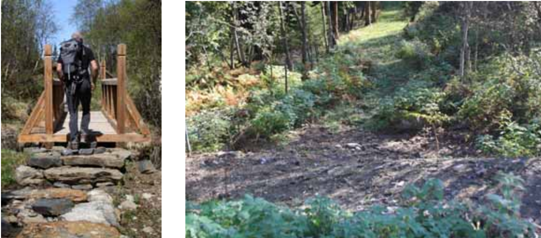
Figur 64. Overgangar er tilrettelagt der vegen er broten av ras, flaum, annan veg eller utbygging. Foto: Katharina Sparstad
