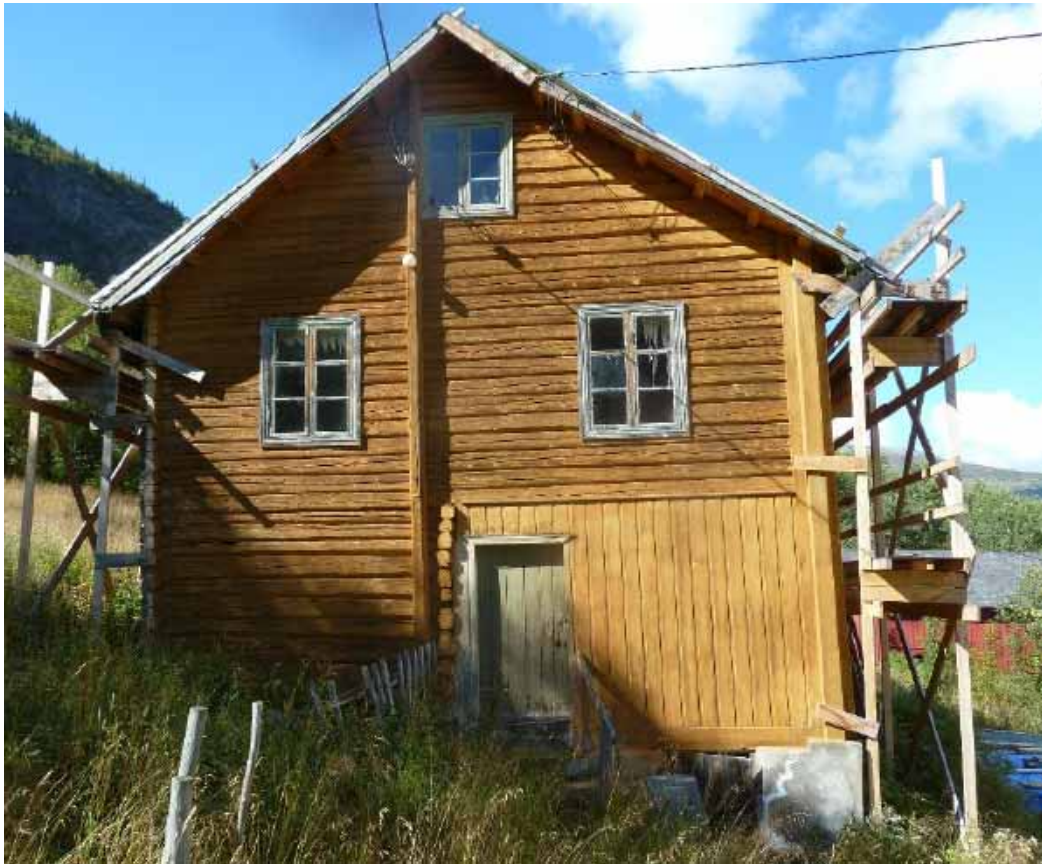
Figur 102. Bua har ein del røteskadar og skal etter planen restaurerast. Foto: Odd Arne Rudi, Valdresmusea
